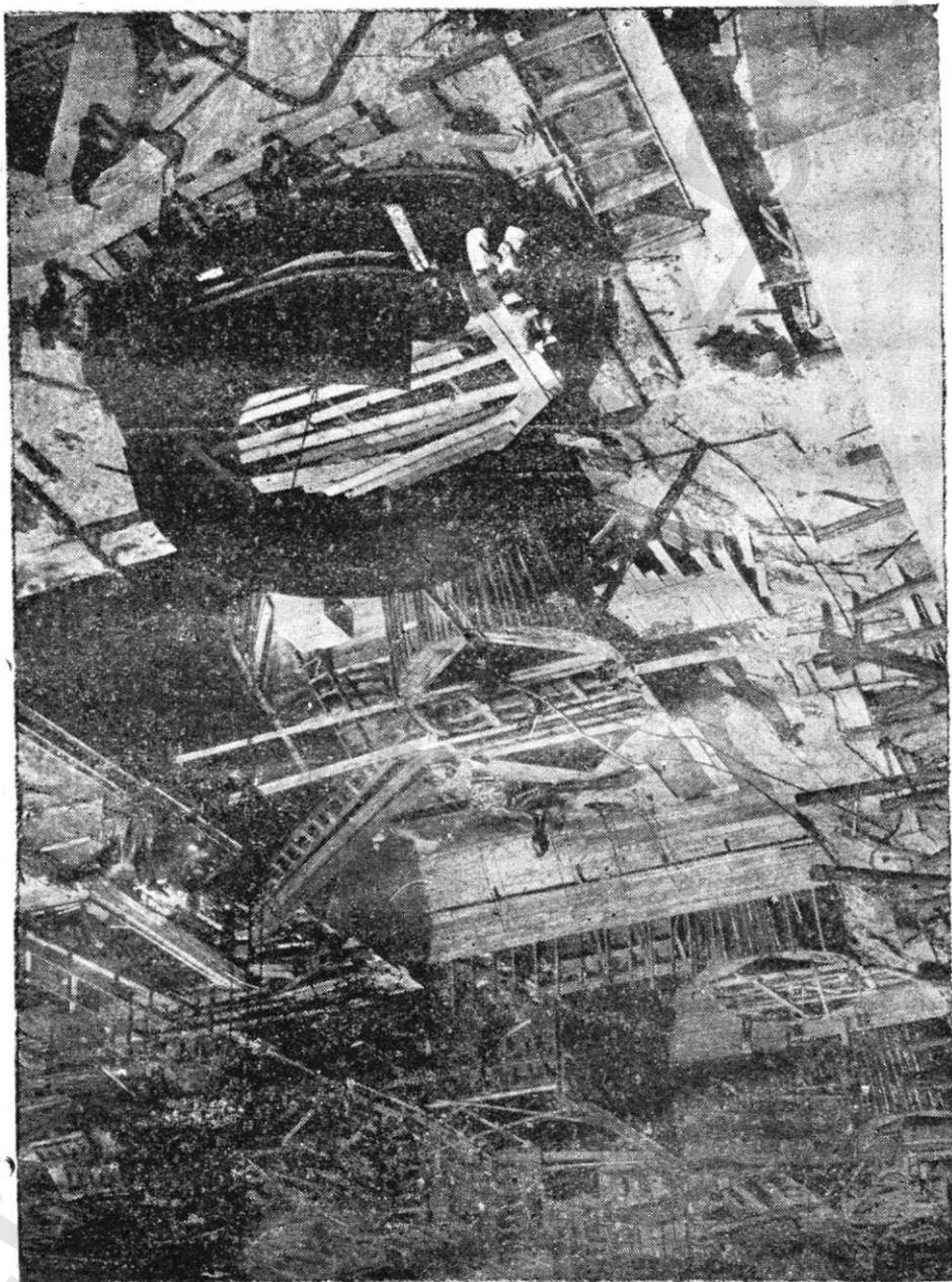
Сборка закладных частей всасывающих труб больших турбин Гидростанции.
