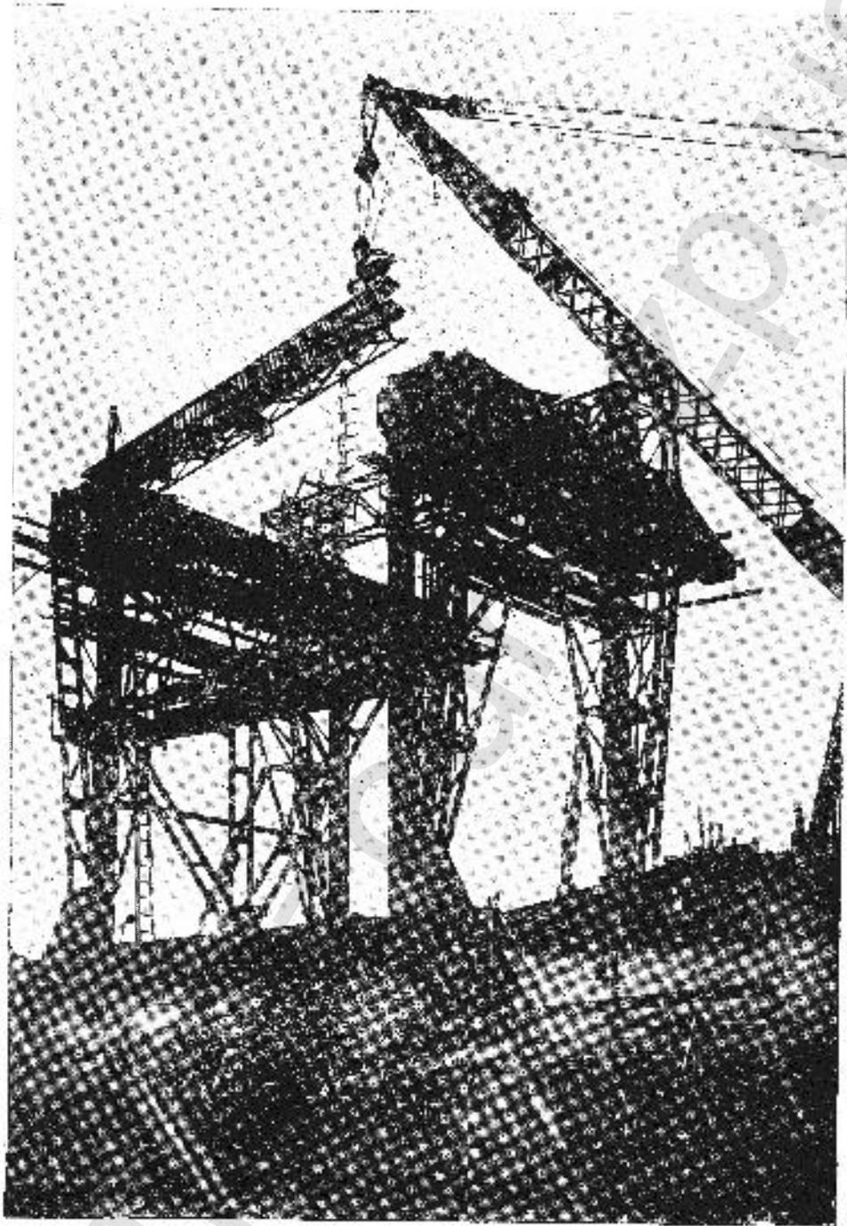
Монтаж портального крана на щитовом отделении ГЭС. Вид со стороны машинного зала.
