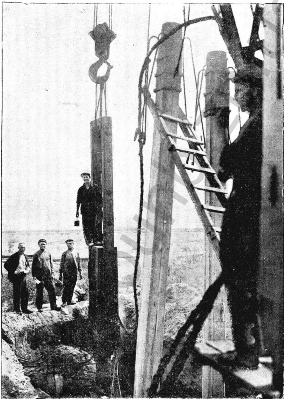
Забивка ж.-бетонных свай на площадке распределительной подстанции.
