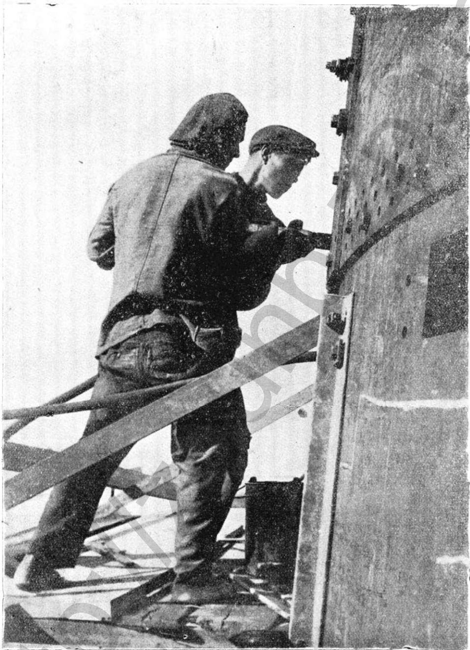
Пневматическая клепка шахты домы № 1 металлургического завода „Днепро-стали“.
