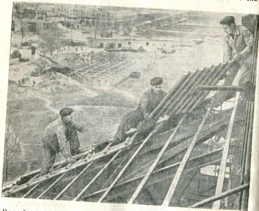
Рис. 34. Монтаж асбестоцементных волнистых плит на кровле разливочной машины
