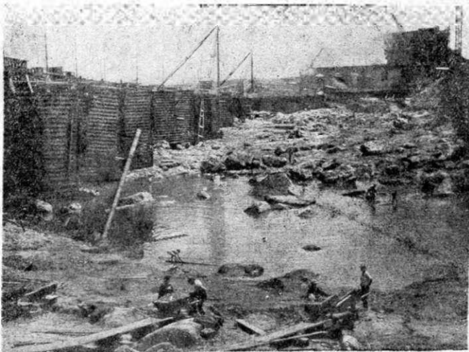
Фиг. 21. Общий вид котлована среднего протока после откачки.
