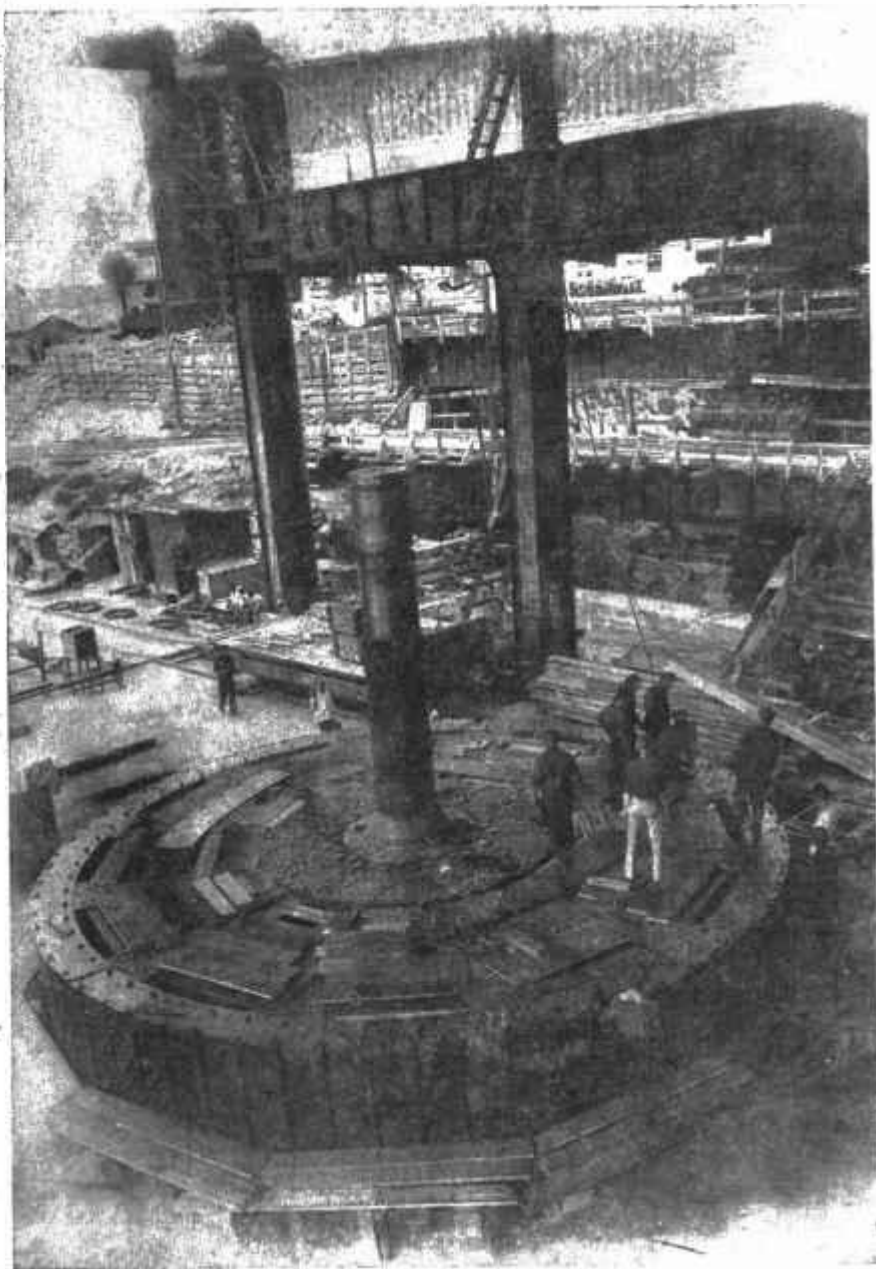
Рис. 25. Монтаж ротора генератора 77 500 ква.
