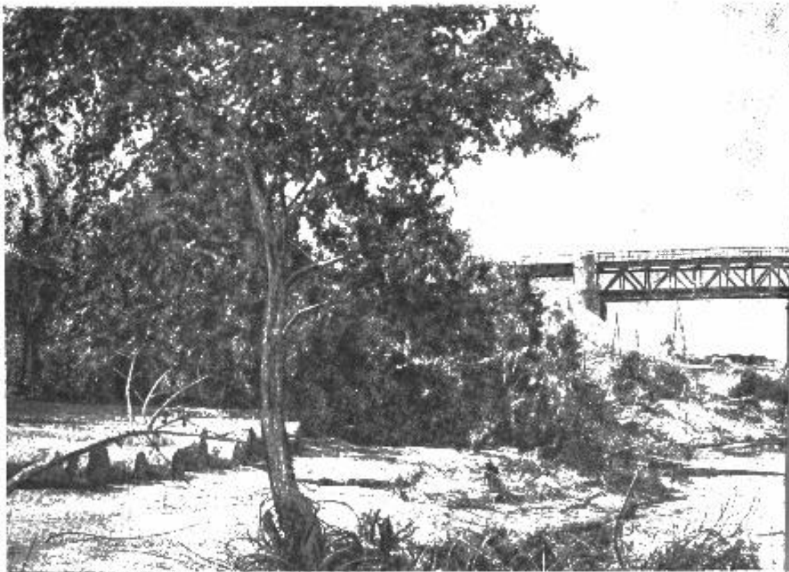
Рис. 31. Мост через р.
