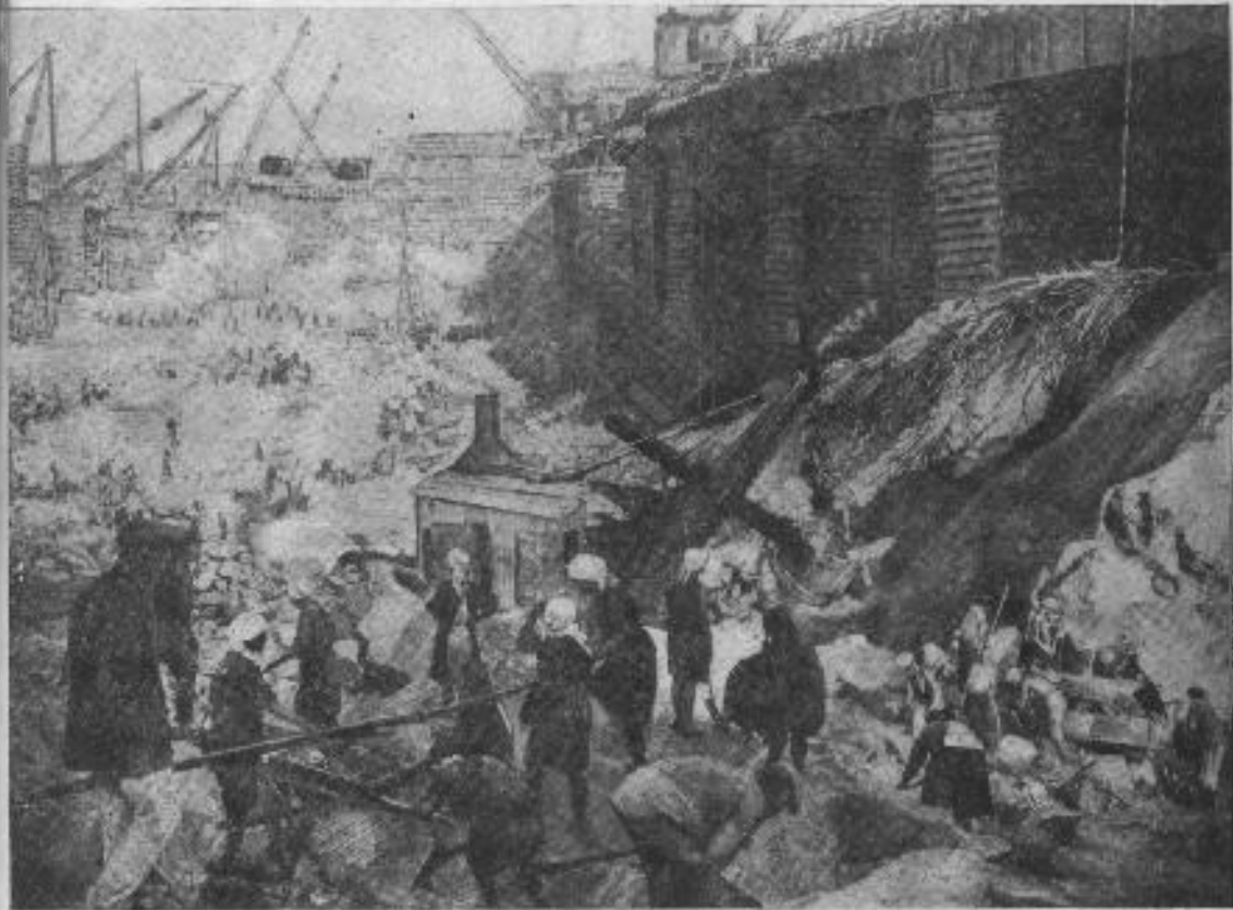
Рис. 89. Работа добровольцев в котловане среднего протока. Июль 1930 г.
