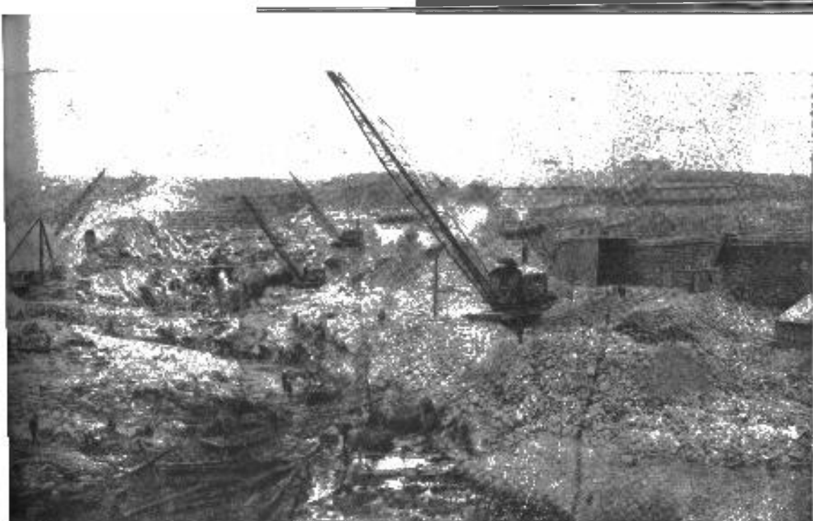
Котлованы в котловане левого протока. Март 1929 г.
