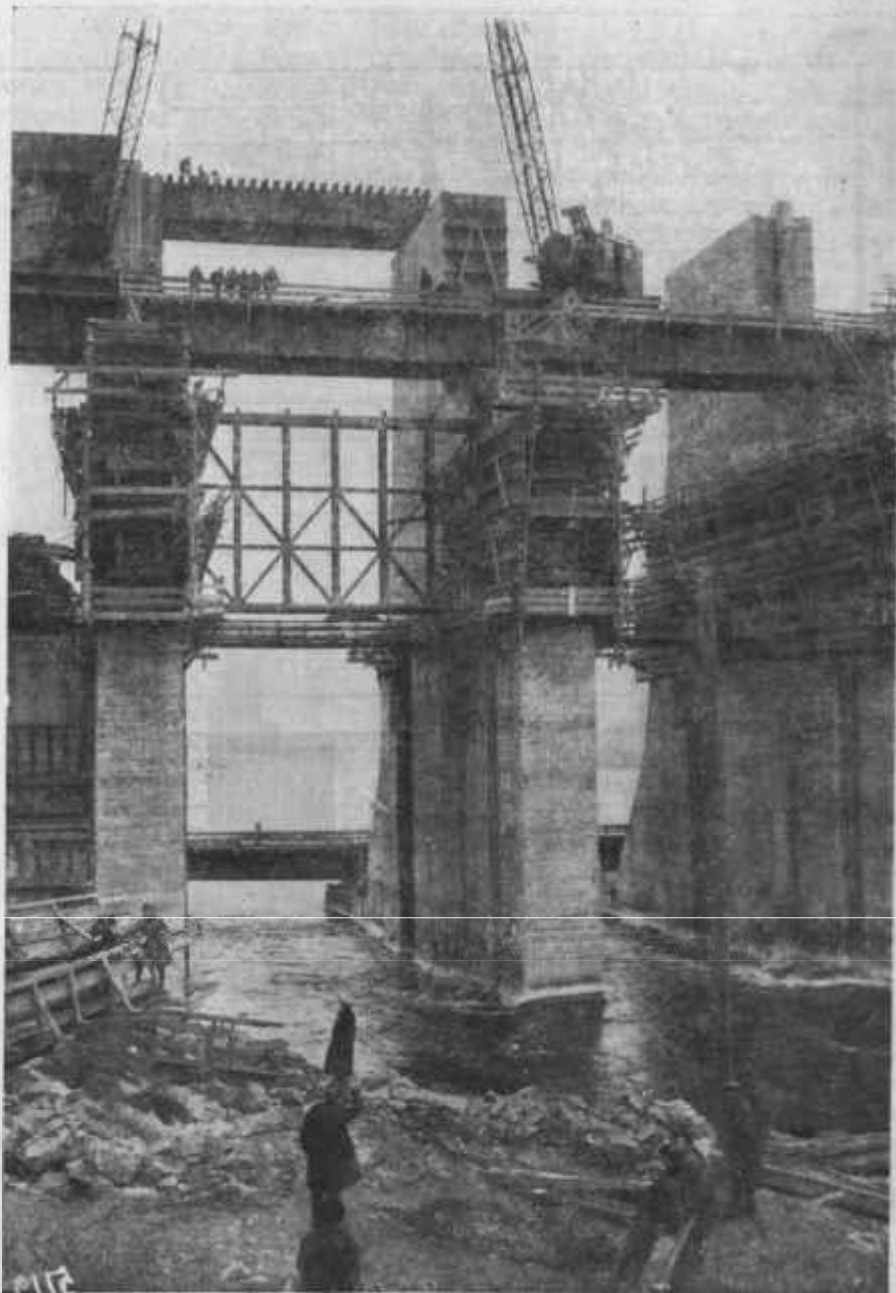
Рис. 62. Опускание металлического каркаса большого щита гребенки.
