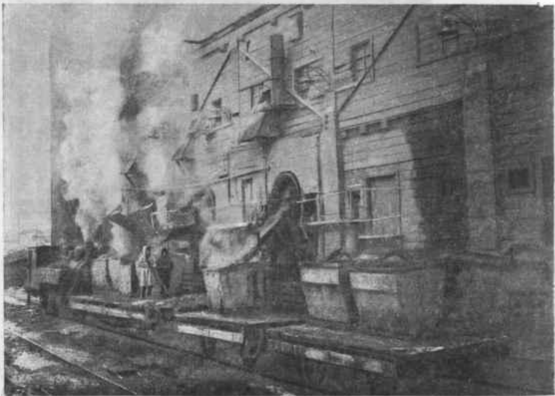
Рис. 77. Бетонный завод. Погрузка бетона в бадьи на поезд.
