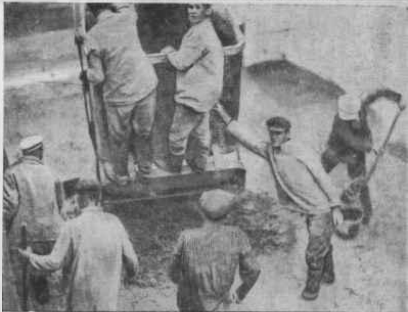
Рис. 78. Открывание бадьи с бетоном.
