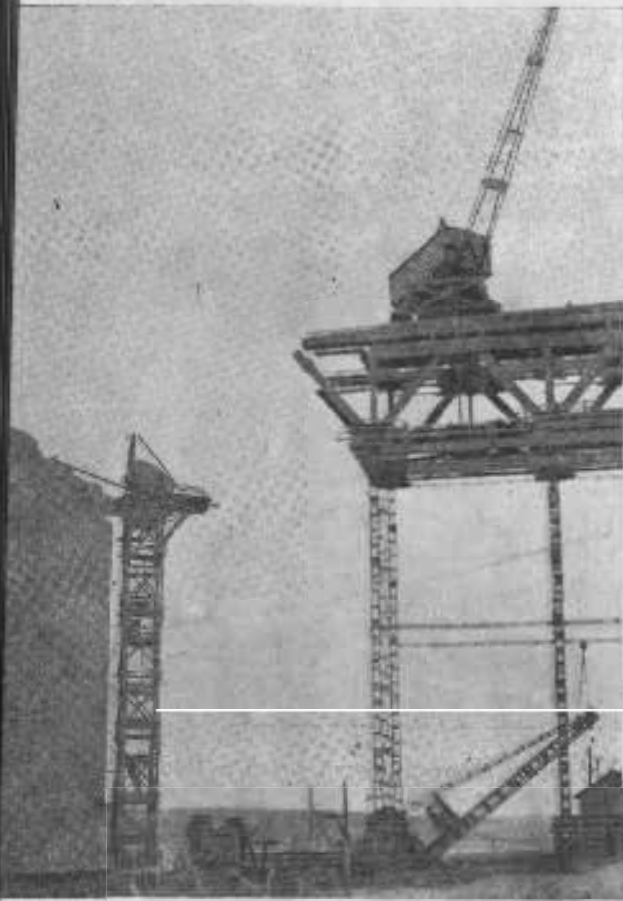
Рис. 88 Сборка левобережной 140-м неразрезной фермы моста через р. Новый Днепр
