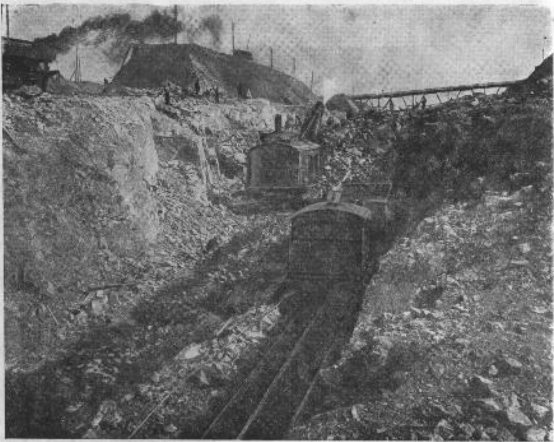
Рис. 69. Скальные работы в шлюзовой лестнице. Сентябрь 1928 г.
