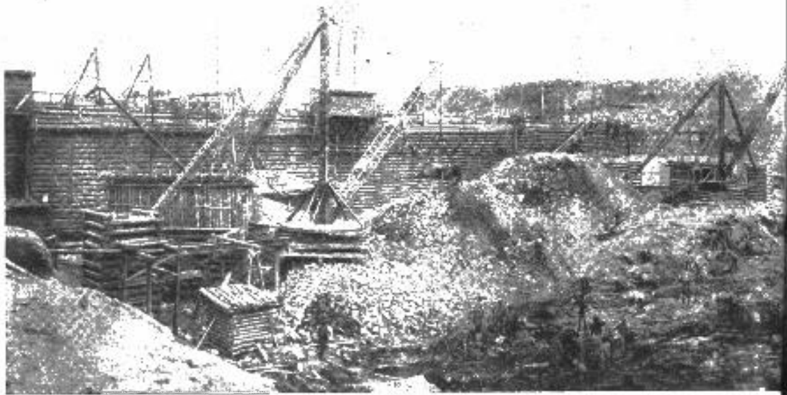
Рис. 51. Разработка скального основания плотины
