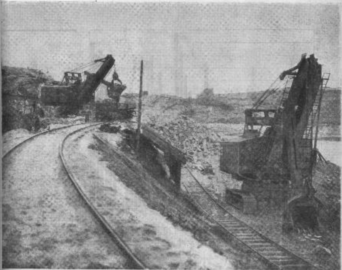
Рис. 70. Низовой подход к шлюзу. Скальные работы на скале Дурной. Ноябрь 1928 г.
