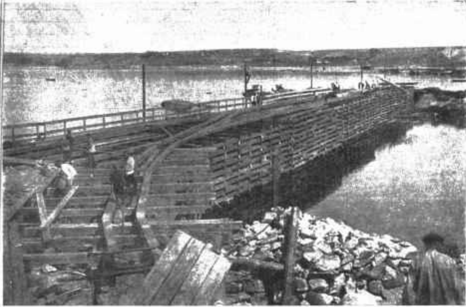
Рис. 46. Постройка ряжевых перемычек.
