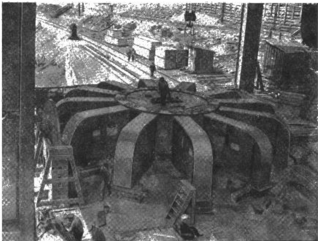
Рис. 23. Монтаж станины (паука) генератора 77 500 кв.
