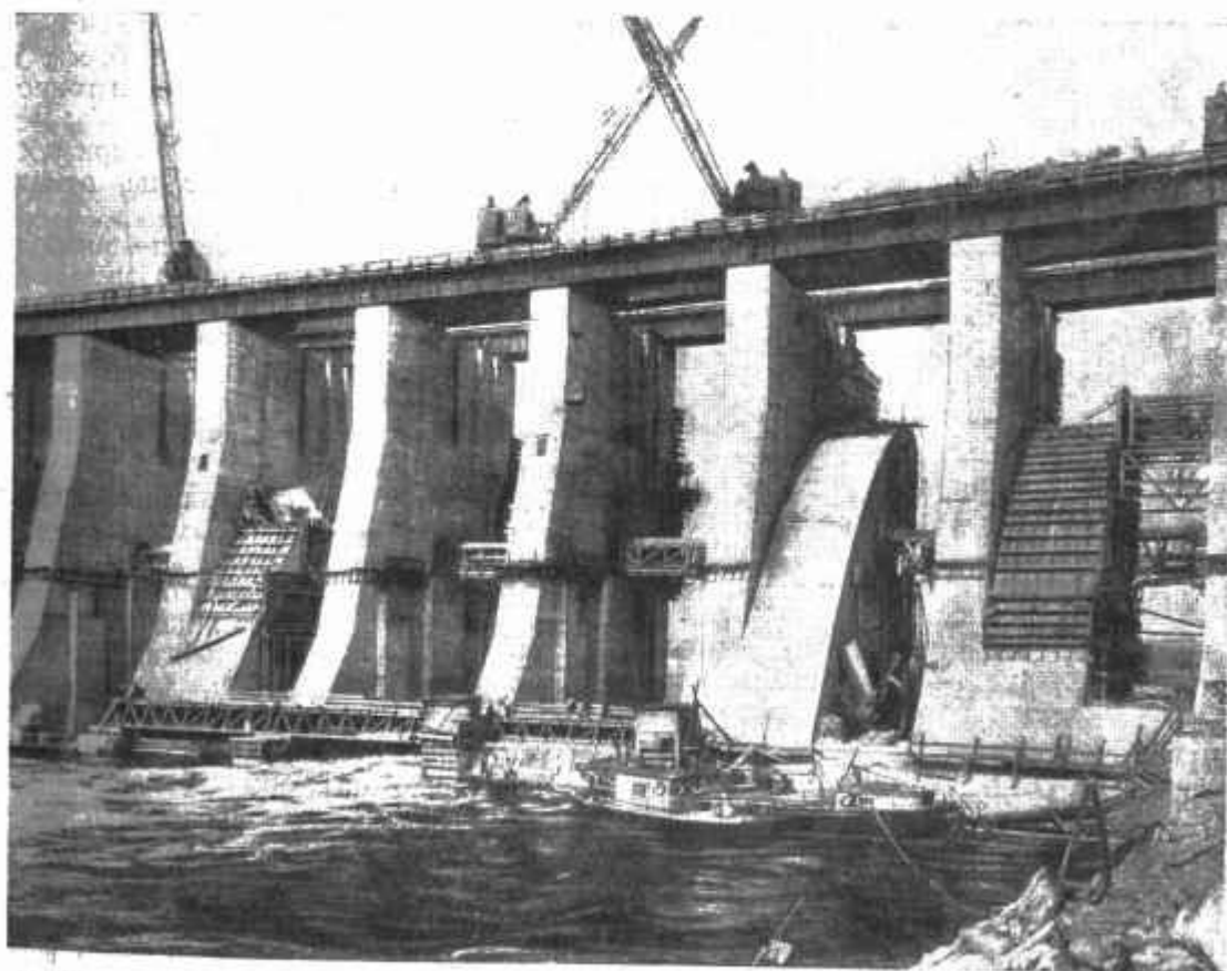
Рис. 11. «Гребенка» плотины. Работа по закрытию водосливных полуролетов. Июль 1931 г.
