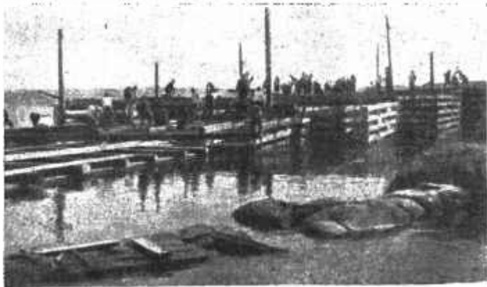
Рис. 15. Изготовление ряжей для перемычек.
