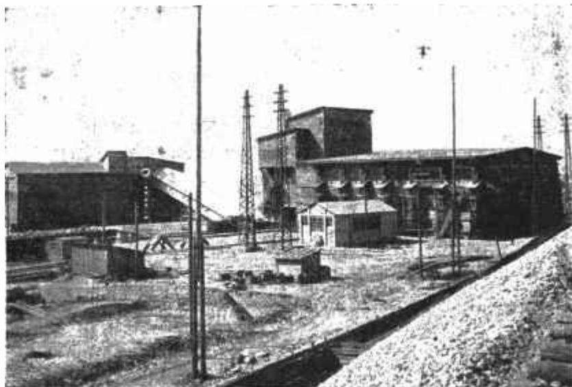
Рис. 11. Камнедробильный и бетонный завод правого берега.
